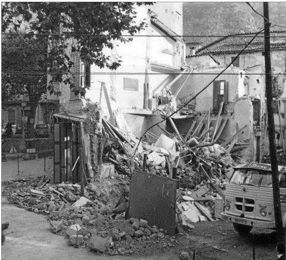
La fi d'aquest emblemàtic local va acabar abruptament a finals d'octubre de 1979, quan s'esfondrà. ■
